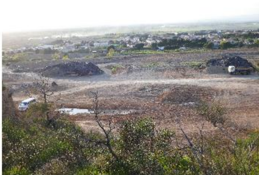
3 Vue du terrain - En fond, Vinassan (2020)
