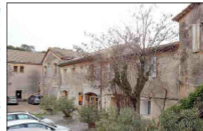
■ Les bâtiments viticoles seront rénovés.
